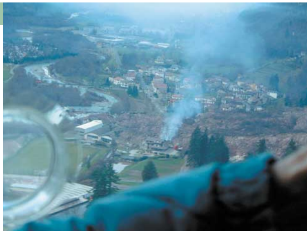
L'enorme frana che ha investito la parte alta di Cortenova.
